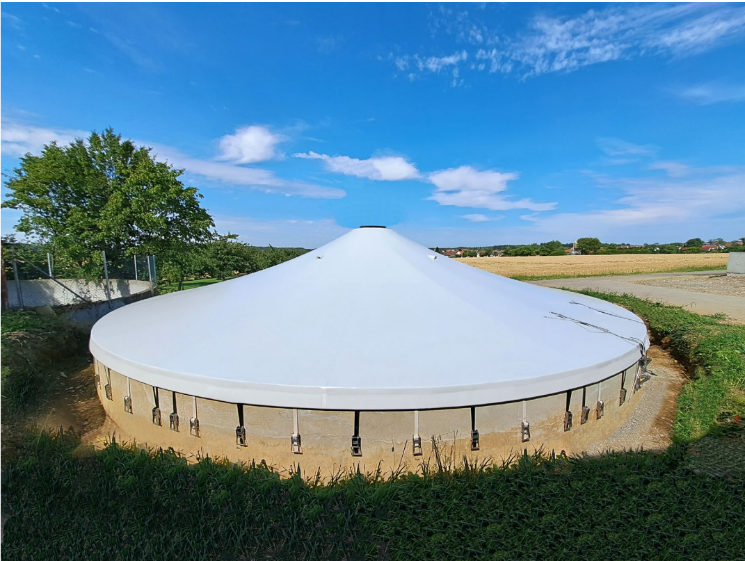
Bild 3: Cogatec freitragendes Emissionsschutzdach | Credit: HUESKER Synthetic GmbH
