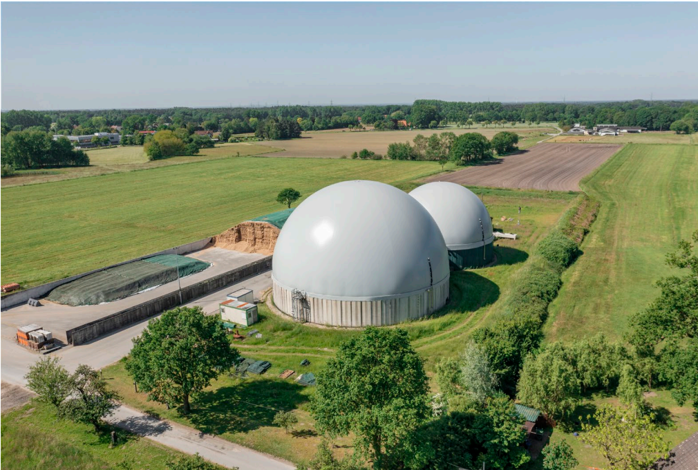
Bild 2: Der Cogatec Doppelmembrangasspeicher ist ein Dachsystem zur Speicherung von Biogas, das auf einen Behälter aufgesetzt wird | Credit: HUESKER Synthetic GmbH
